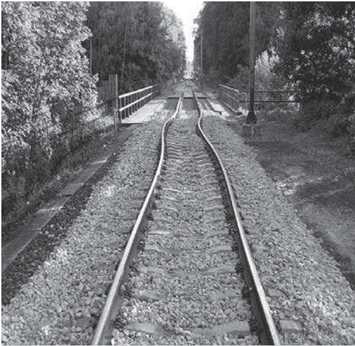
Door de hitte zijn de rails uitgezet.
