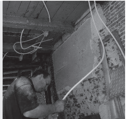
Een elektricien aan het werk.
